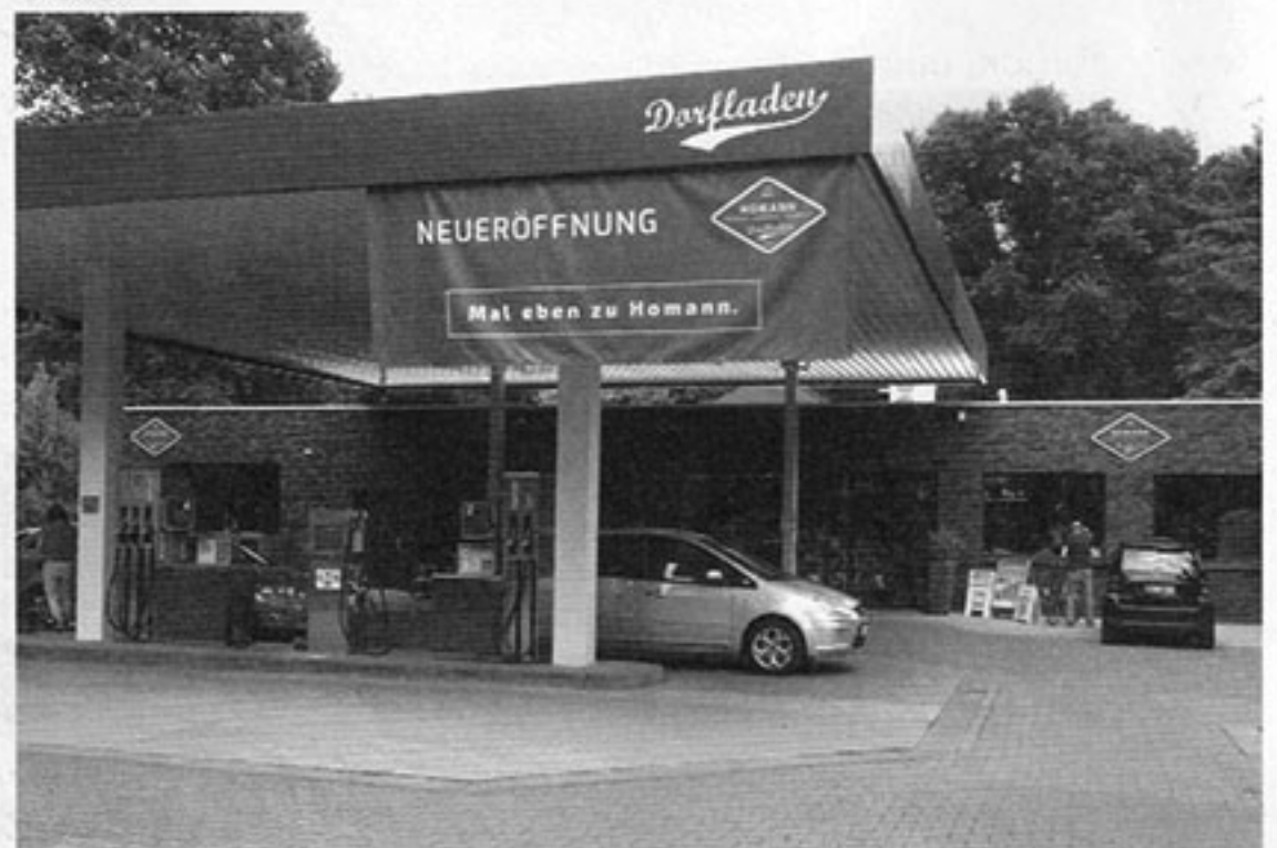
Die Tankstelle Homann in Elte wurde bei laufendem Betrieb umfangreich saniert und überzeugt danach mit einem edlen und modernen Erscheinungsbild.
